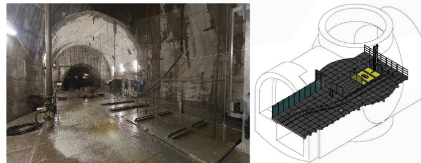
Rys. 4.2 Widok rzeczywisty i wizualizacja 3D pomostu w obrębie wlotu
